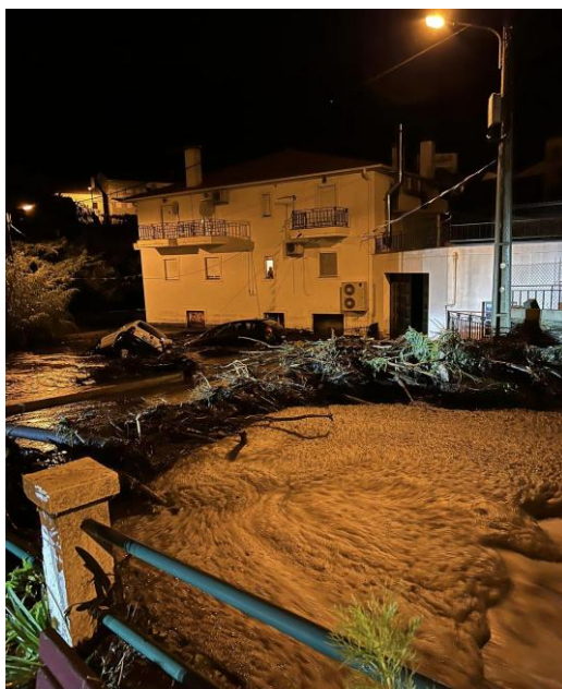
Фиг. 1. Разрушения от наводнението в Самейро, община Мантейгас, област Гуарда, Португалия, 13 септември 2022 г. Снимка: Presidente da Câmara Municipal de Manteigas
